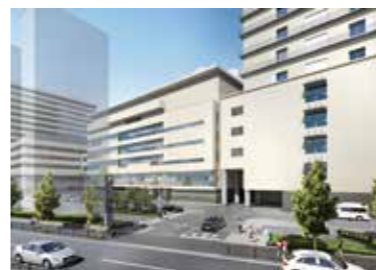
◀新外来棟正面玄関付近（愛宕下通りから）
