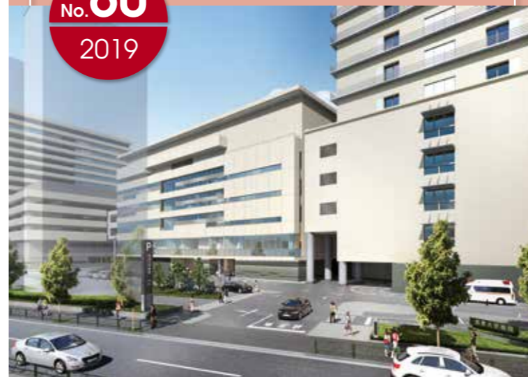
新外来棟外観(愛宕下通り側)
